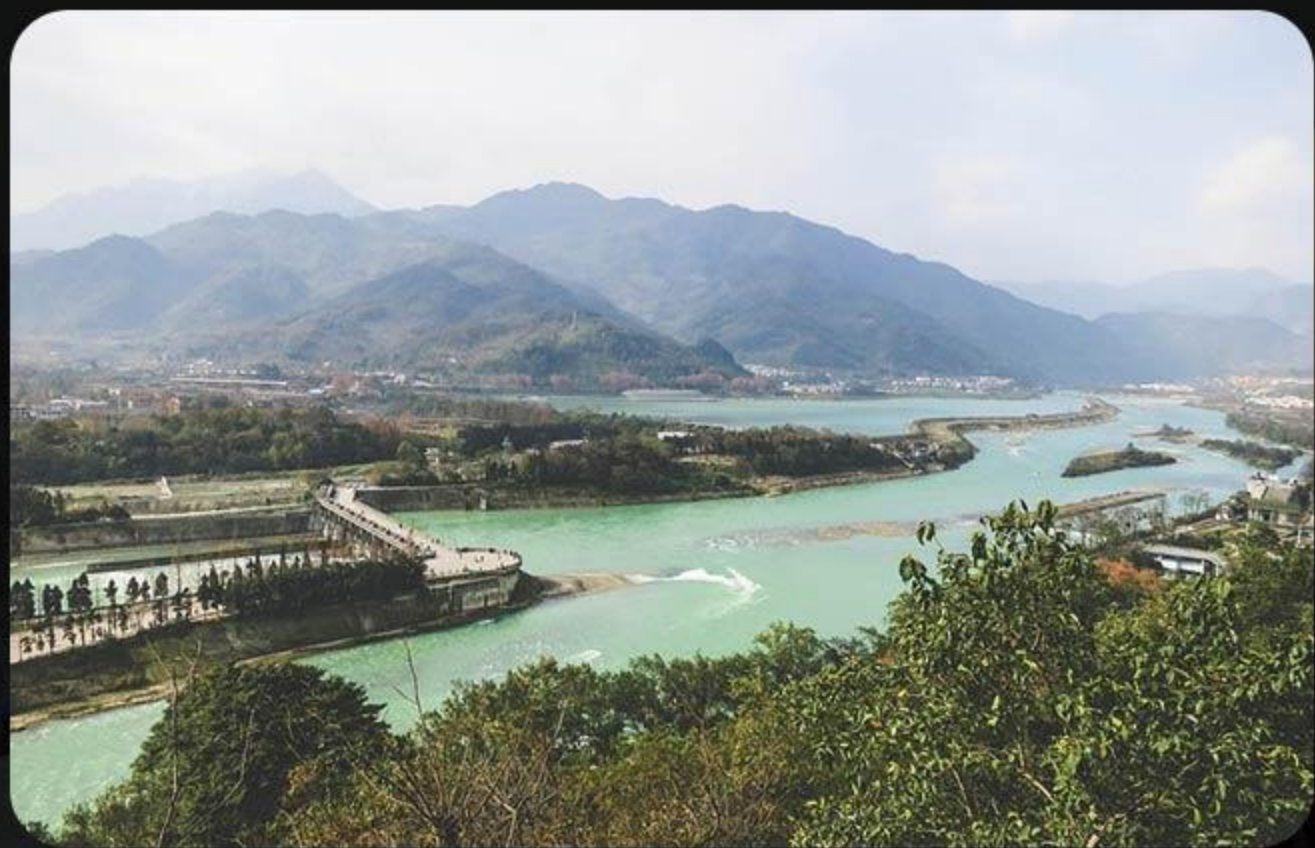
Monitoramento de segurança de Barragem de Conservação de Água
