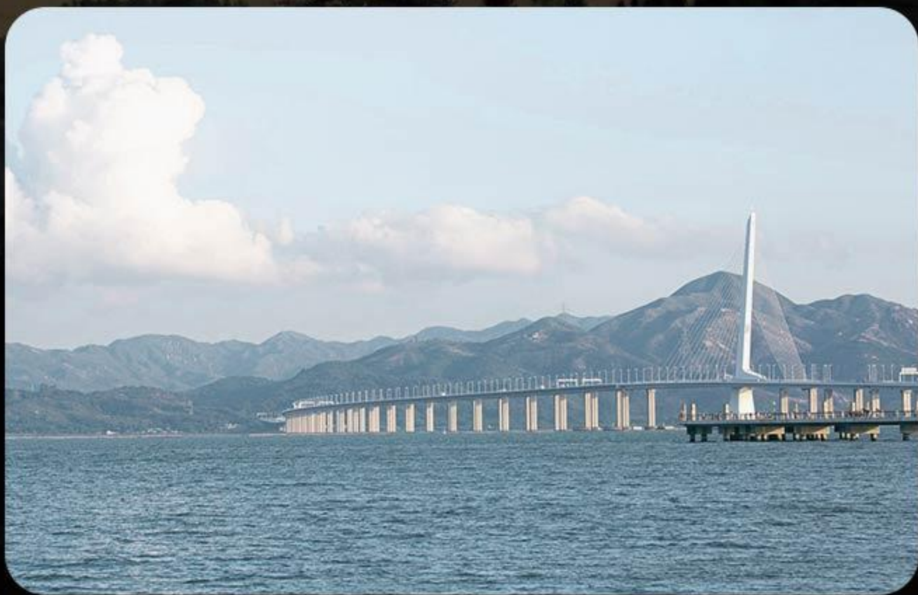
Monitoramento de estrutura de ponte
